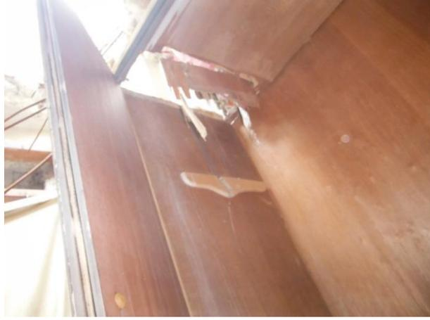
الشكل ٥٠: صورة الضرر الذي لحق بالحمام. ويرجح أن أجزاء من تشكيلة الأسطوانة هي التي سببت هذا الضرر (المصدر: بعثة التقصي)
